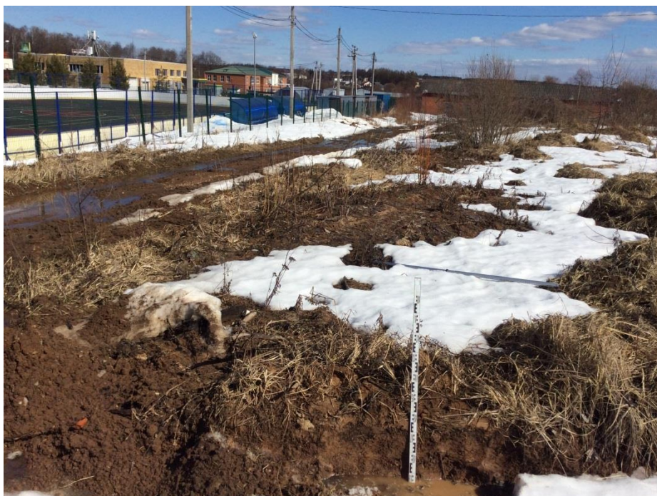
Рис. 24. Участок проведения археологических исследований на объекте: Земельный участок с кадастровым номером 40:14:120801:214 для строительства объекта: «Крытый каток с искусственным льдом в г. Медынь», расположенный по адресу: Калужская область, Медынский район, г. Медынь, ул. Варшавское шоссе, уч. 15В. Место зачистки грунта. Вид с юго-востока.
